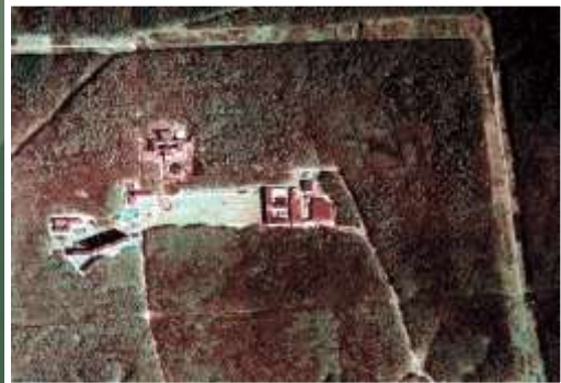
Строения, разрывы линий электропередачи
