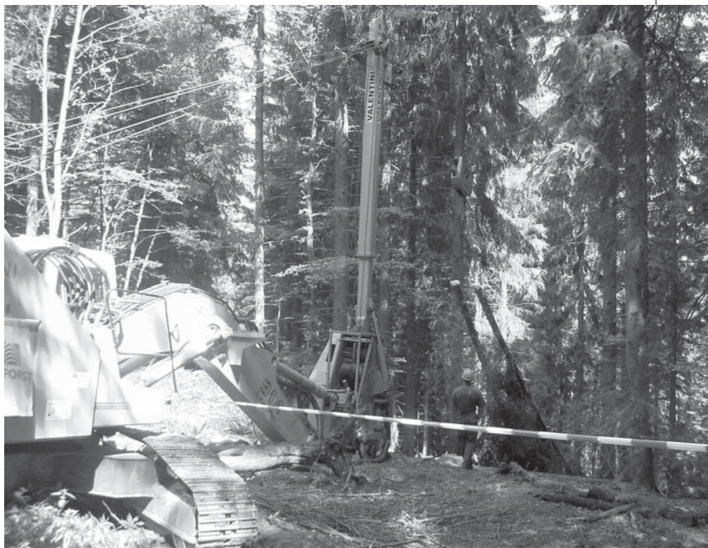
Трелевка целых деревьев канатной установкой на базе экскаватора с самоустанавливающейся мачтой
