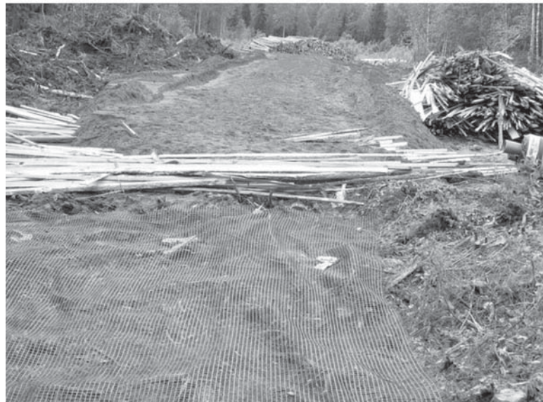
Рис. 6. 2-й вариант. На геосетку укладывался слой отходов лесопиления, на который отсыпался слой грунта
