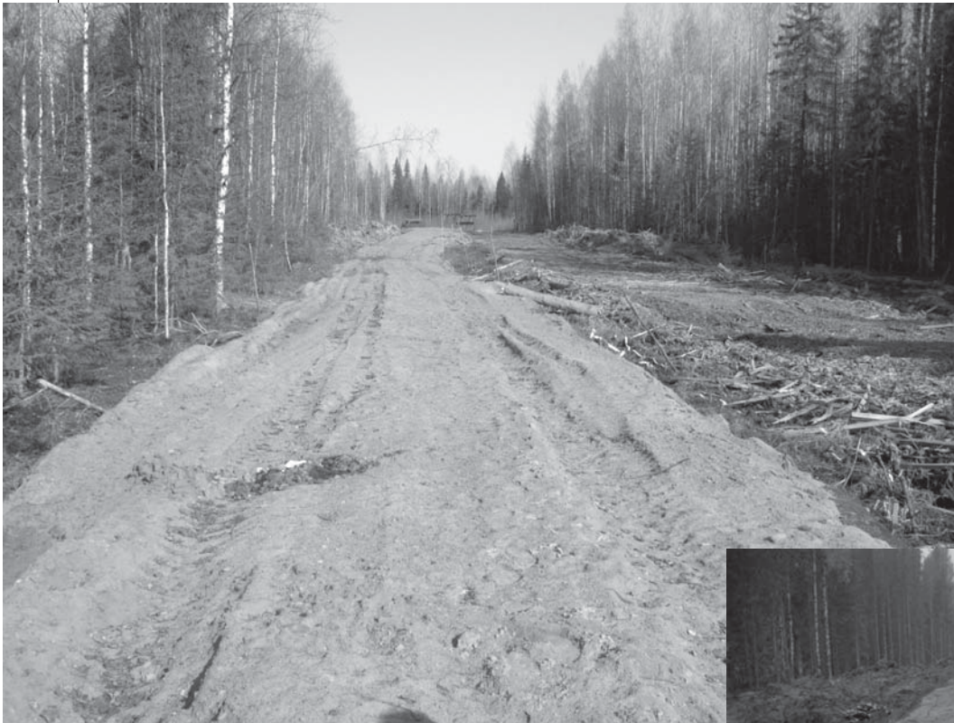
Рис. 7. Вид построенной дороги
