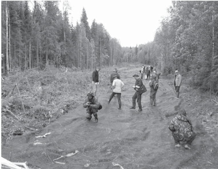
Рис. 5. 2-й вариант. Геосетка укладывается на подготовленное грунтовое основание (пни спиливались в уровень с поверхностью земли, неровности микрорельефа заполнялись лесосечными отходами)
