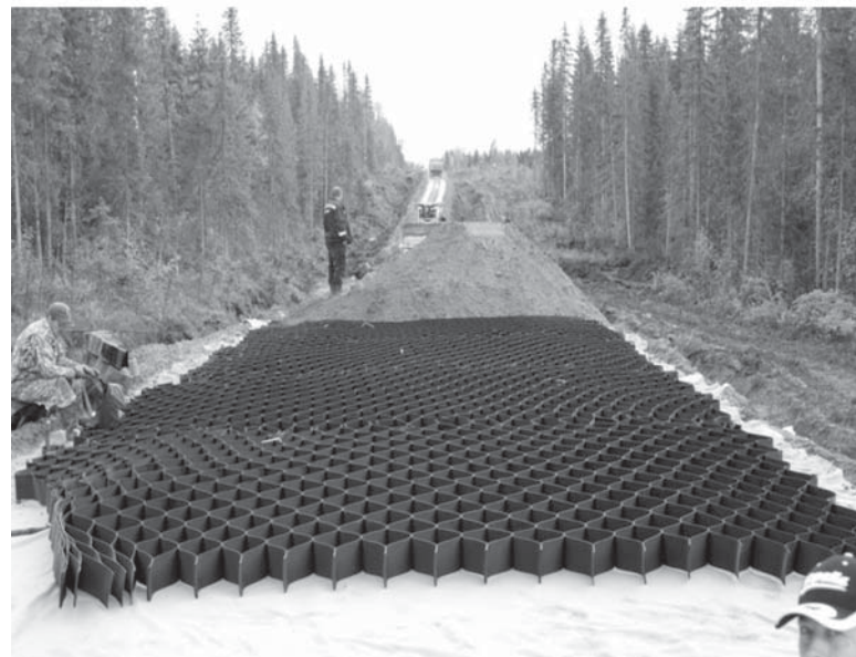
Рис. 8. В строительстве лесных дорог применяются помимо геосеток также геотекстиль и объемные георешетки
