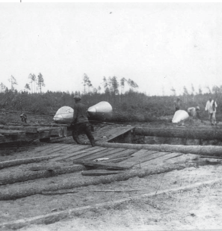
Прибытие на эстакаду лесного склада конусов конструкции ЦНИИМЭ, груженных хлыстами (пример схемы погрузочного лесного склада при трелевке конусов с хлыстами 2-х барабанными лебедками (ЦНИИМЭ-2) применявшаяся в 30-е гг. в Тумской ЛМС).
