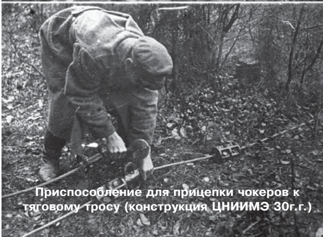
Надевание конуса на увязанный чокером хлыст при валке леса на подкладки. Хлыст приподнимать не приходится
