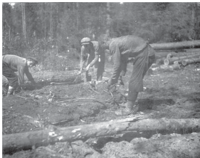
Рис. 12. Приготовление пэна к укладки на него бревен
