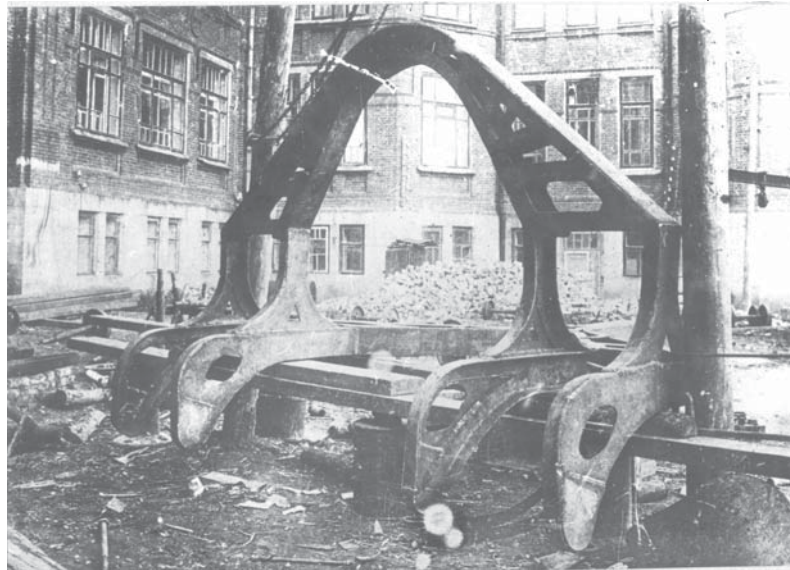
Рис.14. Сварная рама арочного прицепа трелевочного трактора конструкции СевНИИЭЛП в процессе сборки
