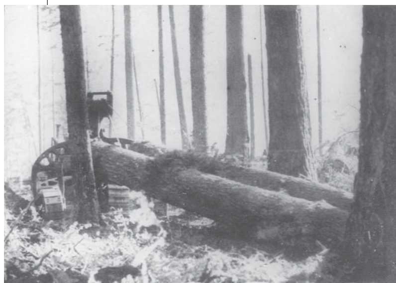
Рис.11. Арочный гусеничный прицеп на тракторной трелевке лесоматериалов с лесосеки выборочной рубки
