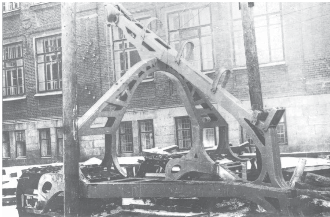
Рис.15. Окончание сборки арочного прицепа конструкции СевНИИЭЛП
