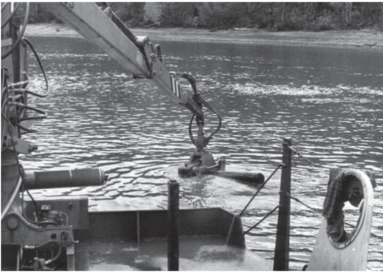
Рис. 1. Скопления затонувшей древесины в водоеме. Подъем топляков
