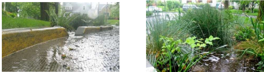
Рис 4. Управление ливневым стоком на северо-восточной зеленой улице Siskiyou, Портланд, США
