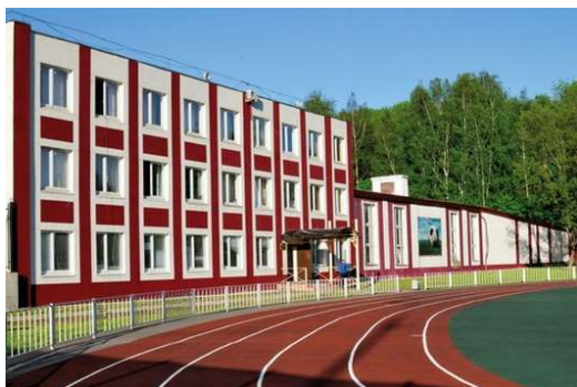
Рисунок 1. СК "Строитель" Административное здание
