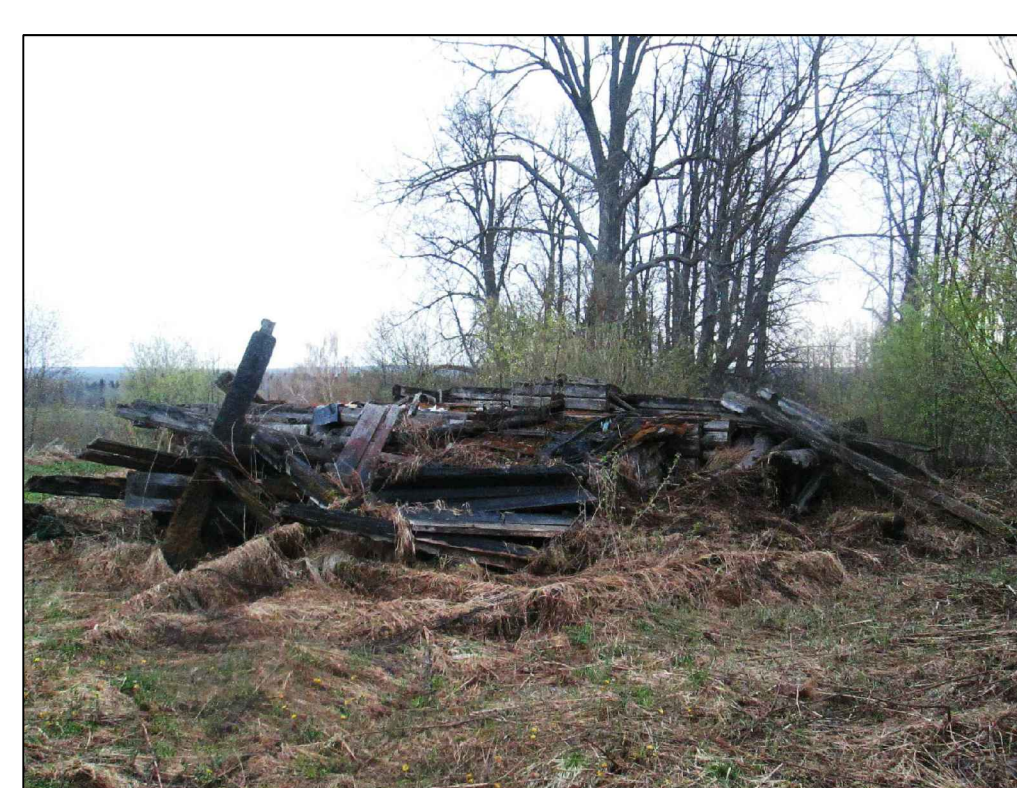
Фрагменты фундамента усадебного дома
