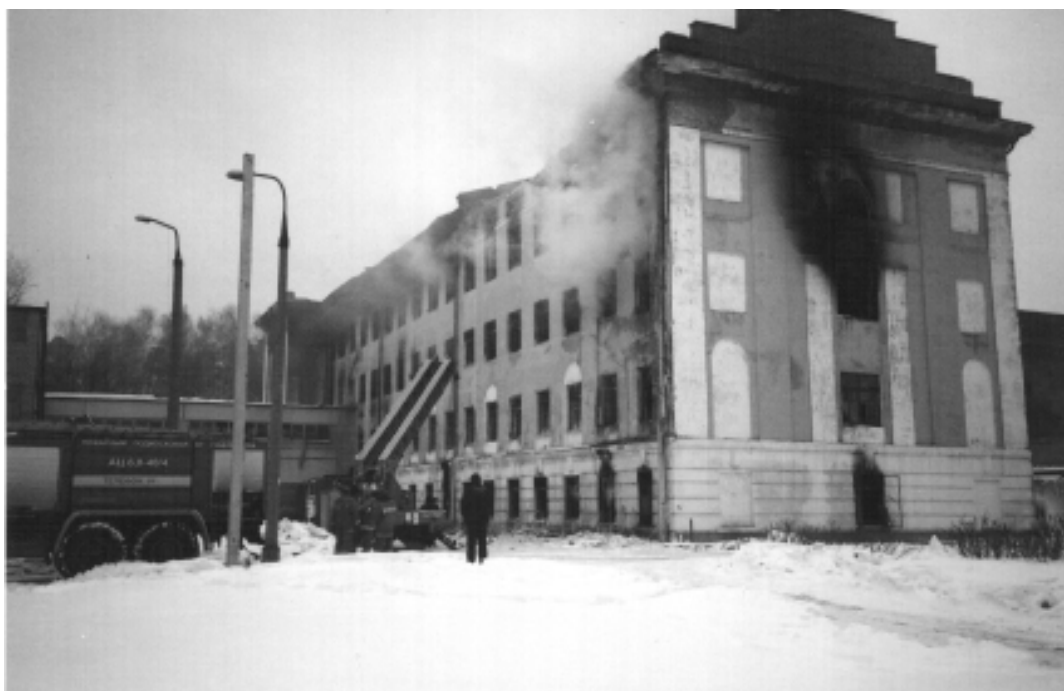
По деревянным перекрытиям огонь от центральной части добрался и уничтожил «крылья» здания
